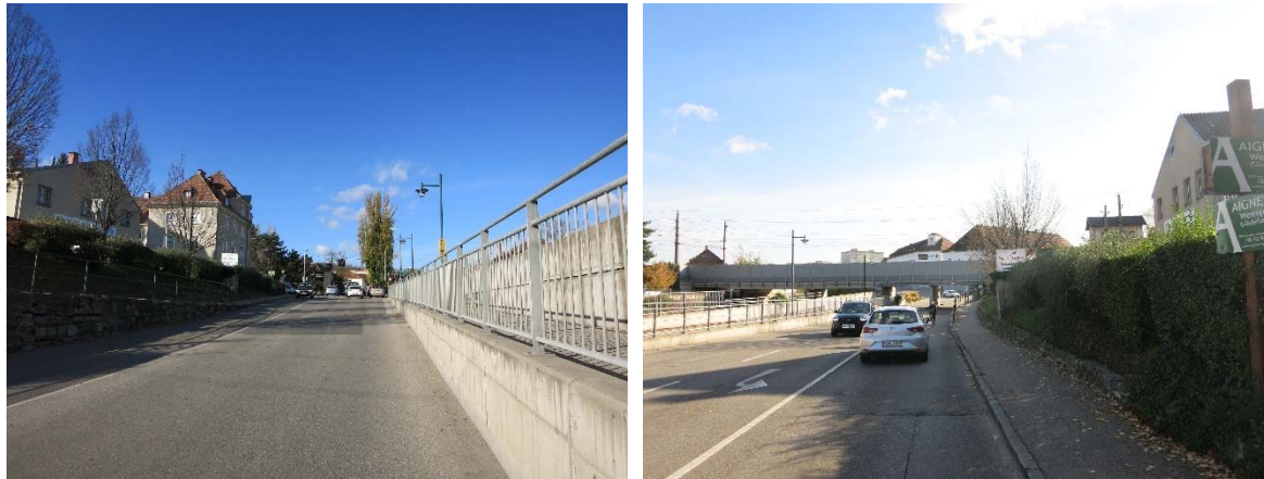
Abbildung 96: Austraße, nördlich der Bahnunterführung
